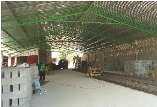
En la **Fábrica de Bloques** de concreto hemos podido techar la nave donde se fabrican y se “curan” los bloques echándoles agua. Pudimos hacerlo gracias a unas estructuras metálicas que nos donaron en “Princess Cruises” y que se convirtieron en las “tijeras”, color verde, que sostienen el techo.
